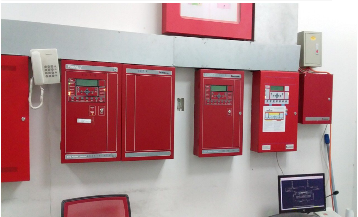
Dự án: Lắp đặt hệ thống báo cháy tự động thuộc dự án Nâng cấp, bổ sung hệ thống Phòng cháy chữa cháy của Nhà máy Z176 – Kiều Kị - Gia Lâm - TP Hà Nội.
