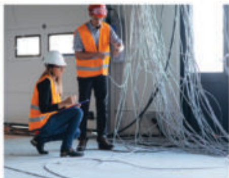
Lắp đặt hệ thống điện
