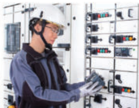
Lắp đặt hệ thống công trình xây dựng khác
