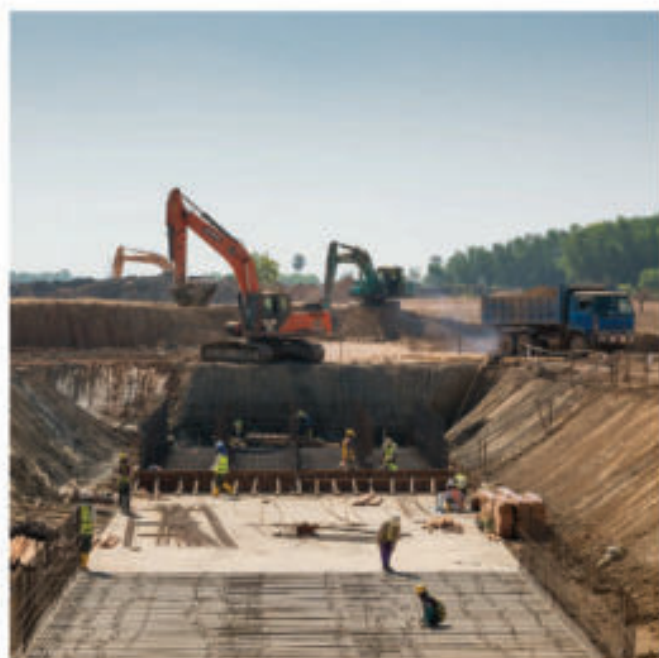
Xây dựng công trình đường sắt, cầu và đường bộ
