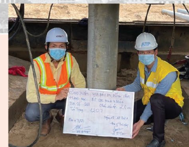
KIỂM TRA CÔNG TÁC ÉP CỌC NHÀ XƯỞNG DỰ ÁN NHÀ MÁY DỪNG TÂM
